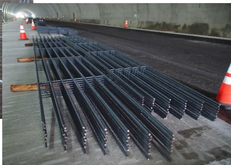
SKP主筋メッシュ SKPメッシュ工法としてNETIS登録品 (住倉鋼材㈱との共同開発品)
