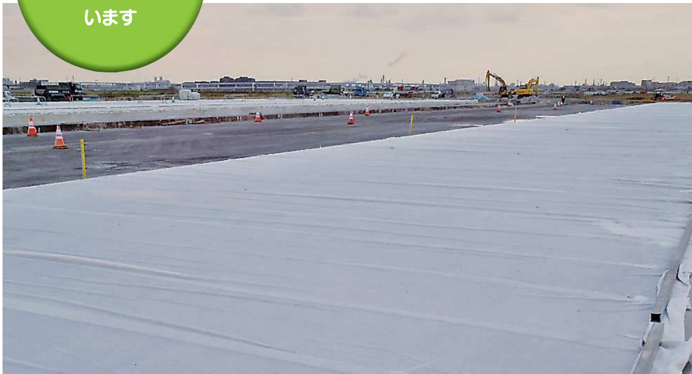
▲コンマツト1号にて養生中現場
